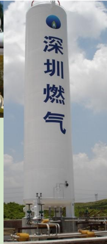
Stationäre Behälter für flüssige Gase
